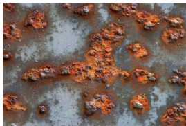
Corrosión del acero inoxidable.
